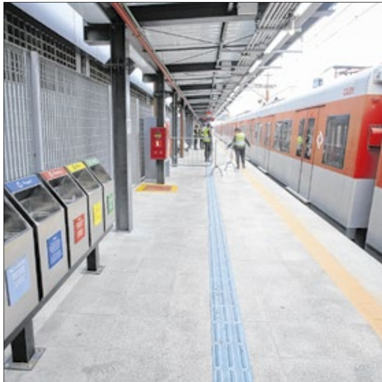
A transição marca a atuação com foco na segurança e a qualidade do serviço
