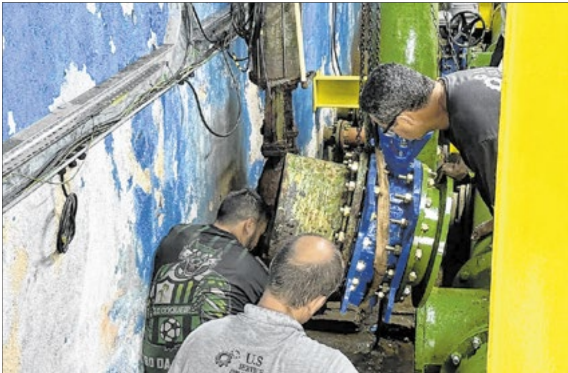
Trabalho de modernização das válvulas dos filtros em Americana é um investimento inédito nas ETAs
