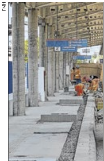
O investimento é de R$ 30 mi e previsão de conclusão em 2027
