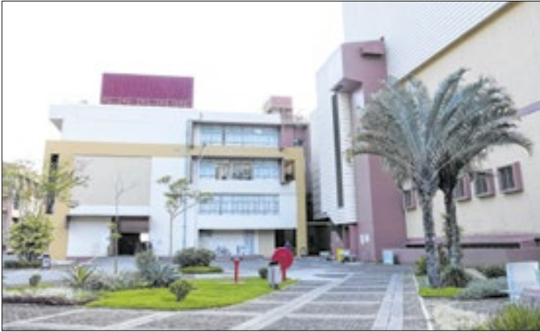
Instalações da Usina de Angra 1 na Central Nuclear Almirante Álvaro Alberto (CNAAB), em Angra dos Reis, no Rio de Janeiro
