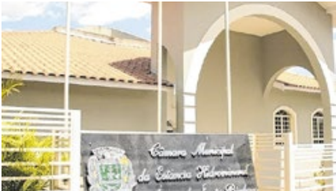
Câmara de Águas de Santa Bárbara sofre golpe
