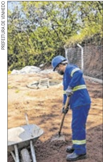
Sistema terá monitoramento remoto das elevatórias de esgoto
