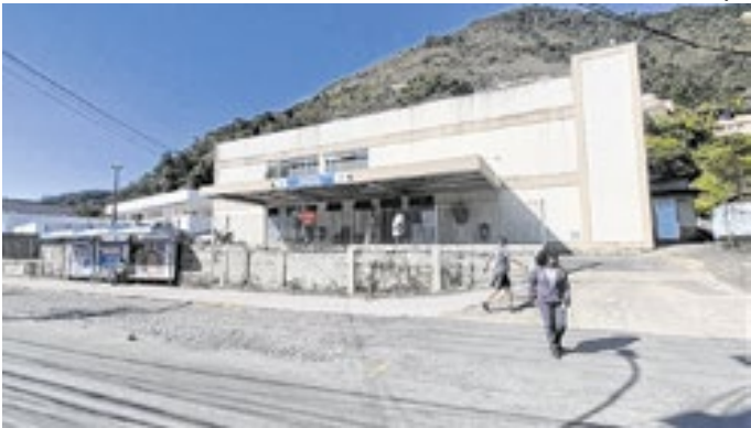
Estado diz que vai monitorar adequações do posto
