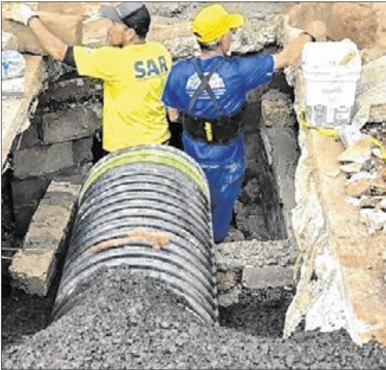
Obras no cruzamento das avenidas Júlio e Amâncio Gaiolli foram finalizadas
