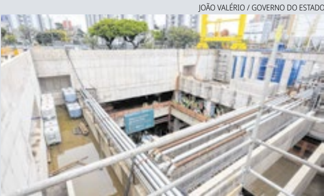
Prefeito de Guarulhos acompanha início das obras
