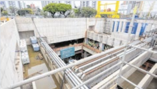
Prefeito de Guarulhos acompanha início das obras
