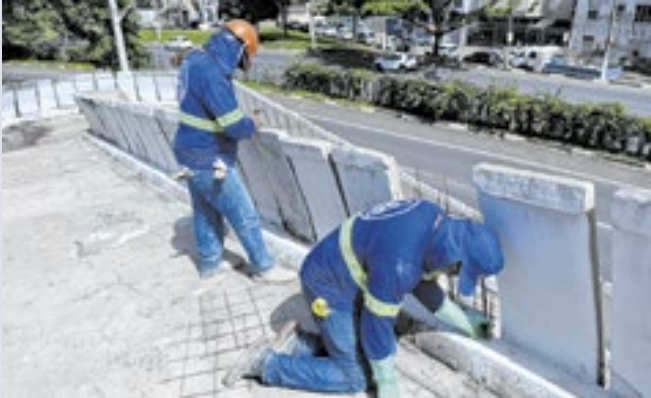
Manutenção do guarda-corpo da passarela sobre a Aquidabã
