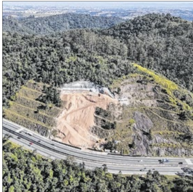
Intervenções incluem contenção, melhorias e monitoramento de chuvas
