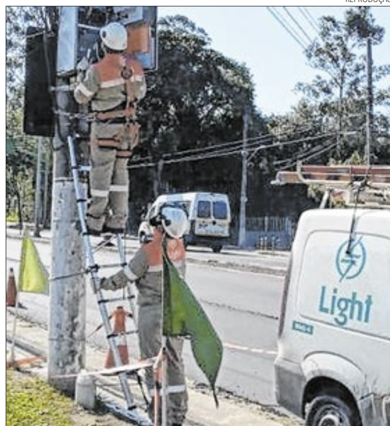
Equipes da Light realizam reparos na rede elétrica
