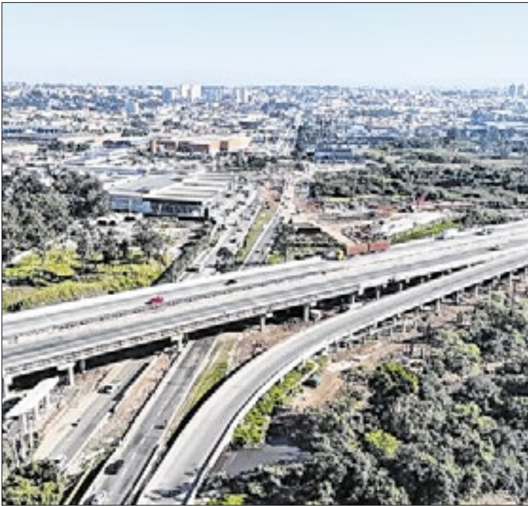
Rodovia Poá-Suzano onde será realizada a obra no rodoanel
