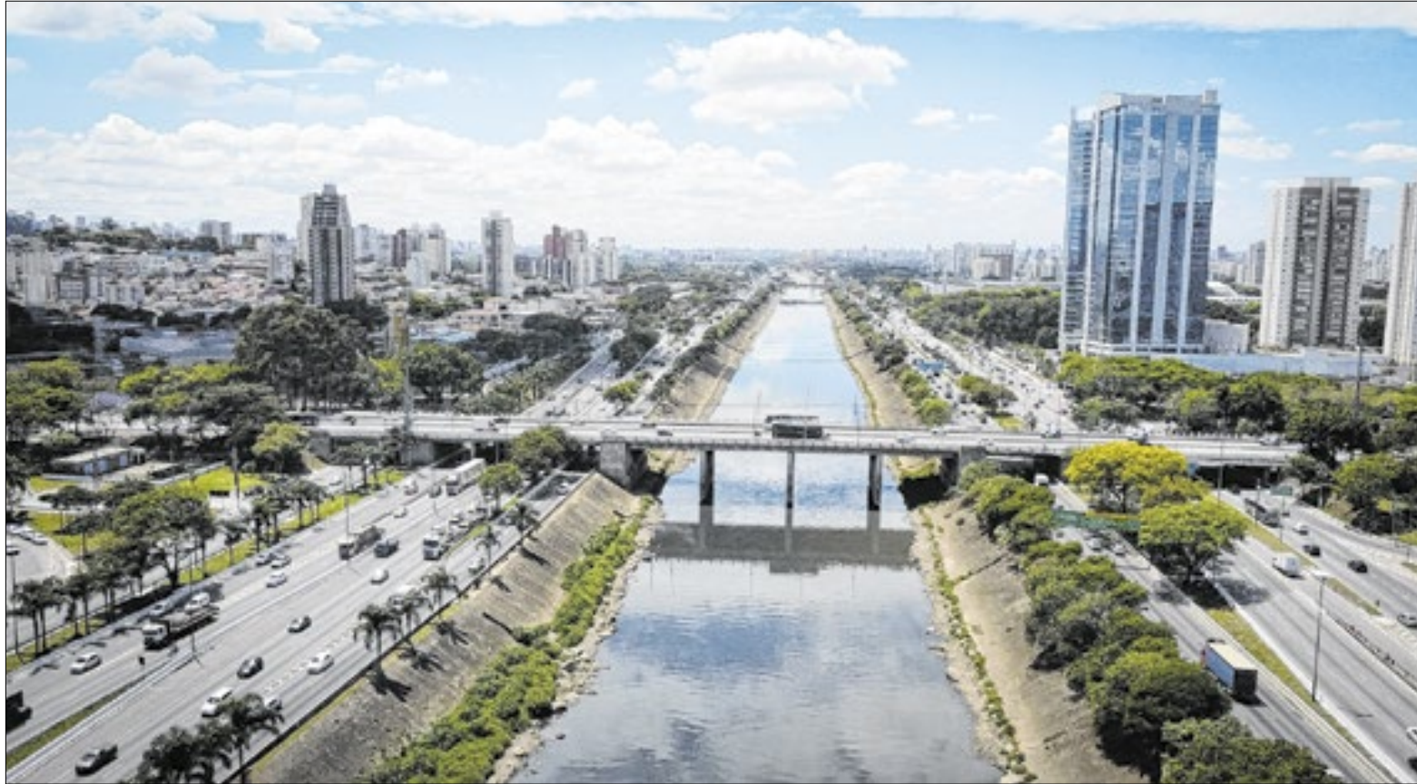
Rio Tietê registra redução na carga de poluição orgânica após obras de saneamento, mas ainda recebe esgoto sem tratamento na região
