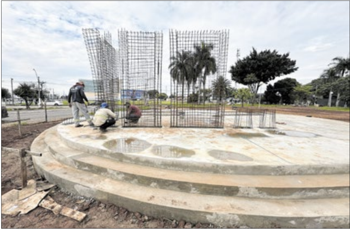
Estrutura de sustentação das esculturas começou a ser montada em área urbana localizada entre duas avenidas
