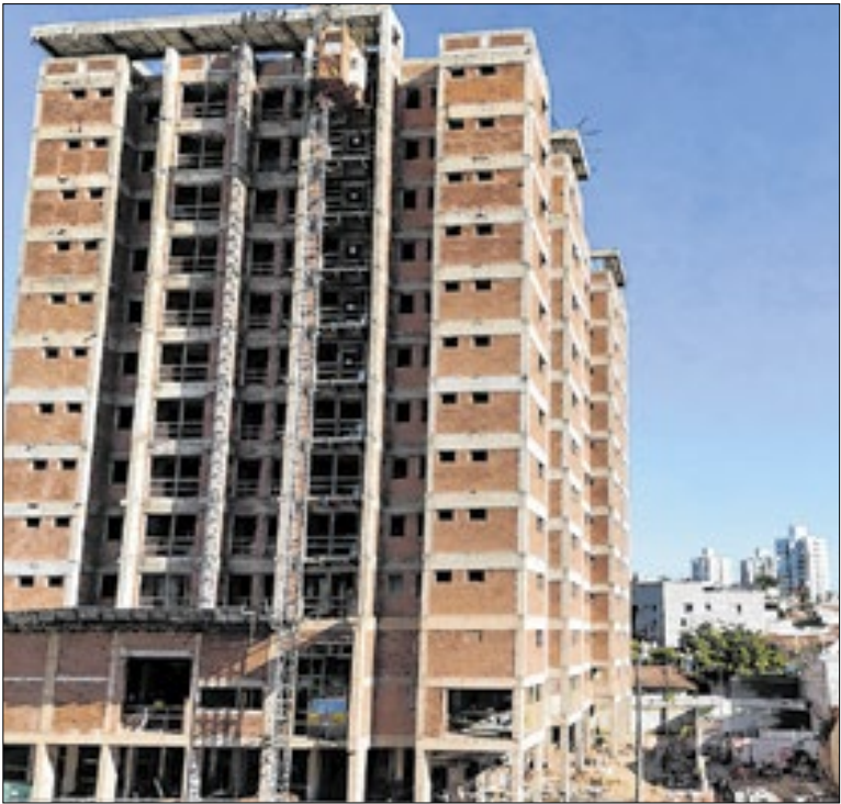
A construção civil abriu 1,3 mil vagas com carteira assinada no período
