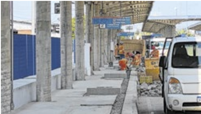
Com investimento de R$ 30 mi, previsão de conclusão é fevereiro de 2027
