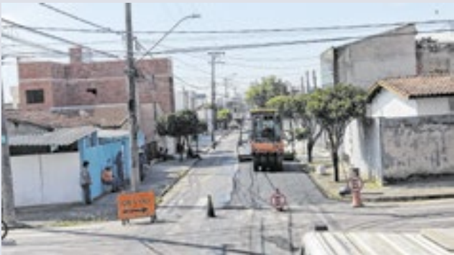
No total, rua receberá nova pavimentação a 980 metros lineares
