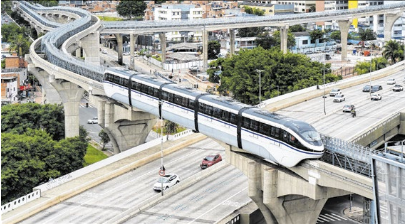
Linha 17-Ouro liga o Aeroporto de Congonhas à rede sobre trilhos e já transportou mais de 500 mil passageiros
