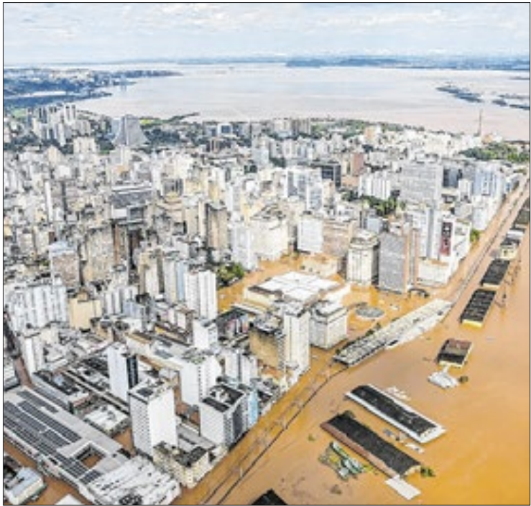
Um relatório de 2023 pedia reparos no Sistema de Proteção Contra Cheias
