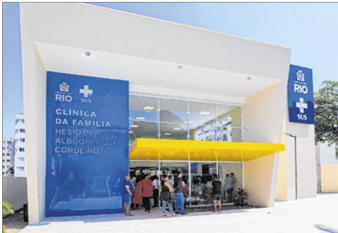
Unidade combina ampliação do atendimento, conforto térmico e modernização dos espaços
