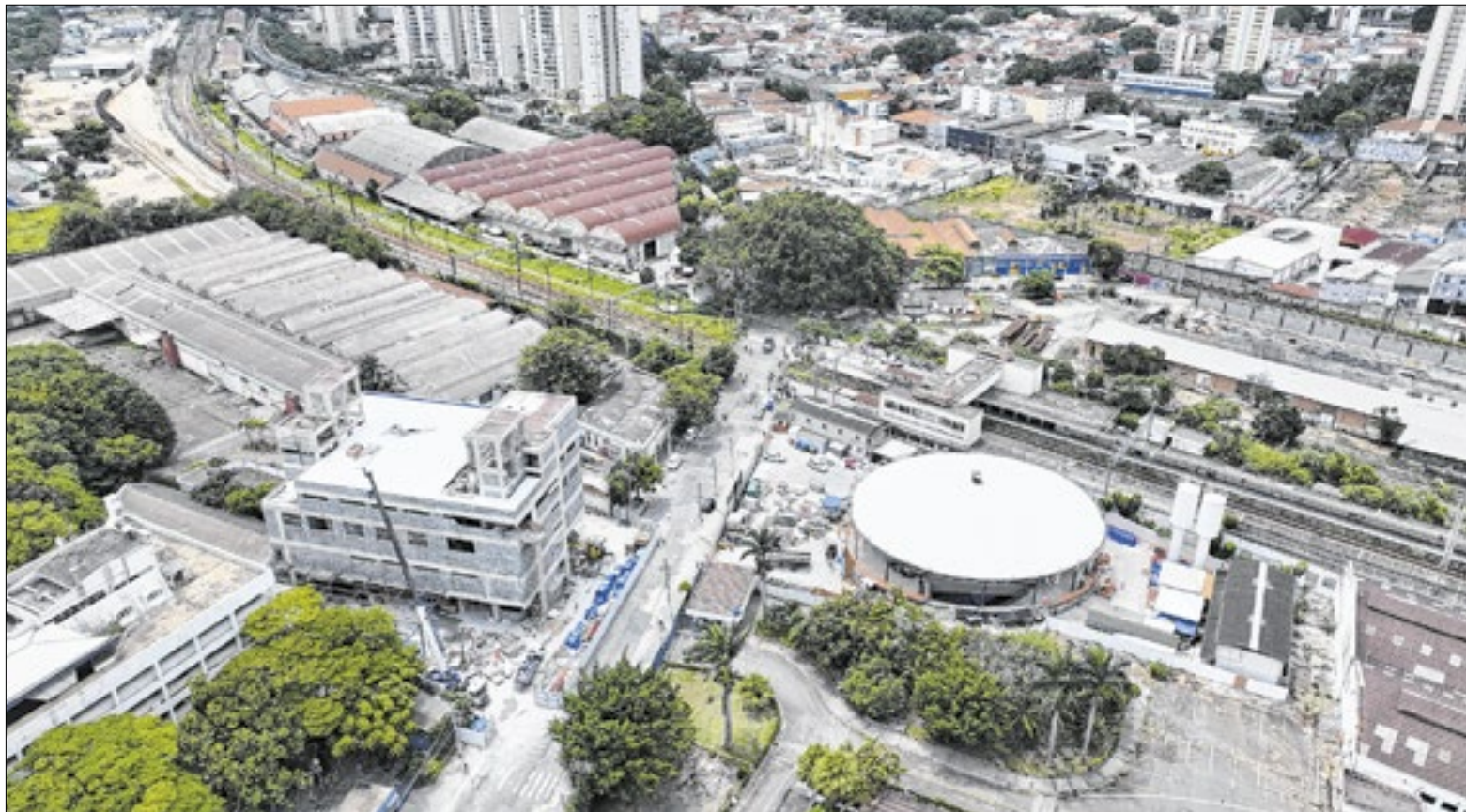
Área na Água Branca, Zona Oeste de São Paulo, será destinada à implantação da nova estação ligada ao projeto do TIC Eixo Norte
