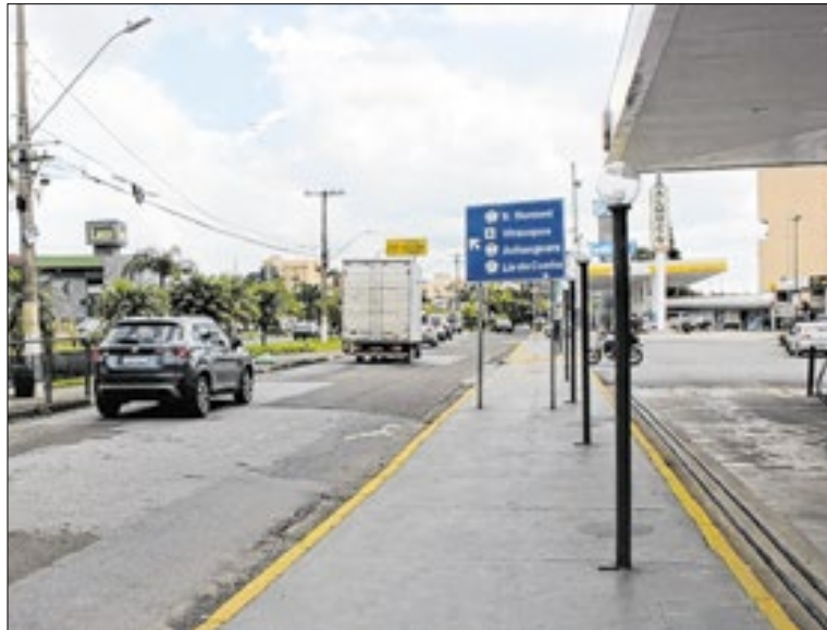
Ampliação da alça de acesso da avenida Benedicto Campos à Prestes Maia
