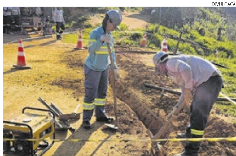
Águas do Rio está implantando cerca de três quilômetros de novas redes de distribuição em Cabuçu
