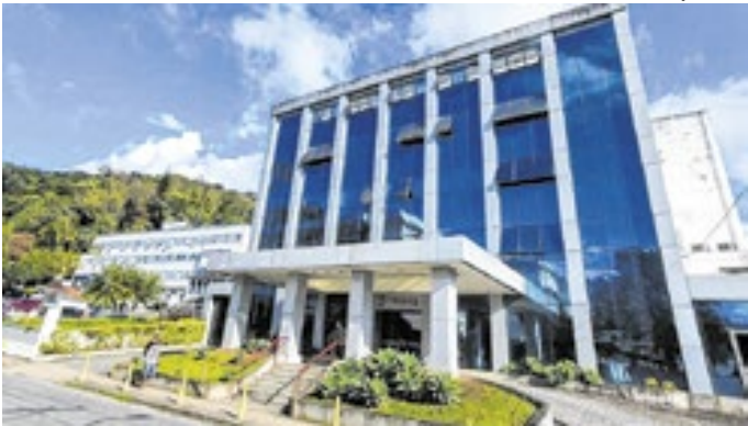
Prédio do hospital SMH Beneficência Portuguesa de Petrópolis
