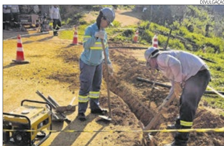
Águas do Rio está implantando cerca de três quilômetros de novas redes de distribuição em Cabuçu
