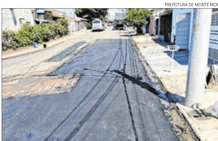
Equipes realizaram serviços de manutenção em diferentes regiões
