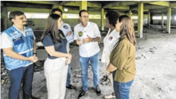
Obras do hospital estão paradas desde 2013
