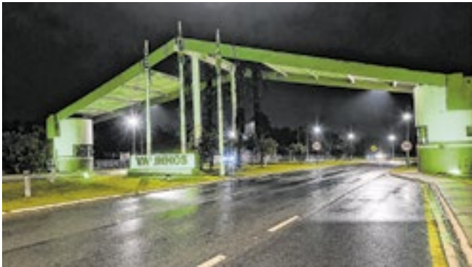
Portal iluminado na cor verde devido ao ‘Setembro Verde’
