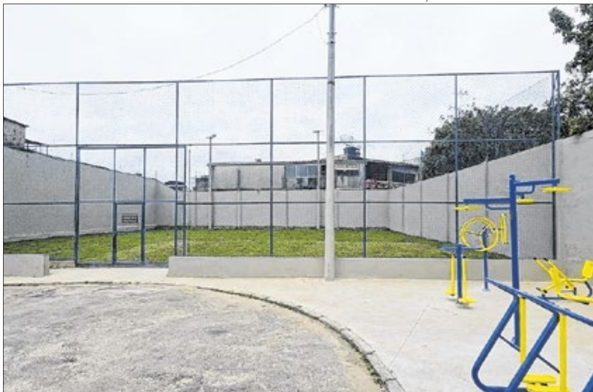
Obras de drenagem, pavimentação e requalificação de redes de água e esgoto chegaram a mais de 37 mil m 2
