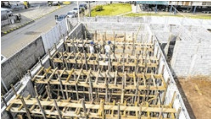
Montagem das escoras marca nova etapa das obras do estande de tiro
