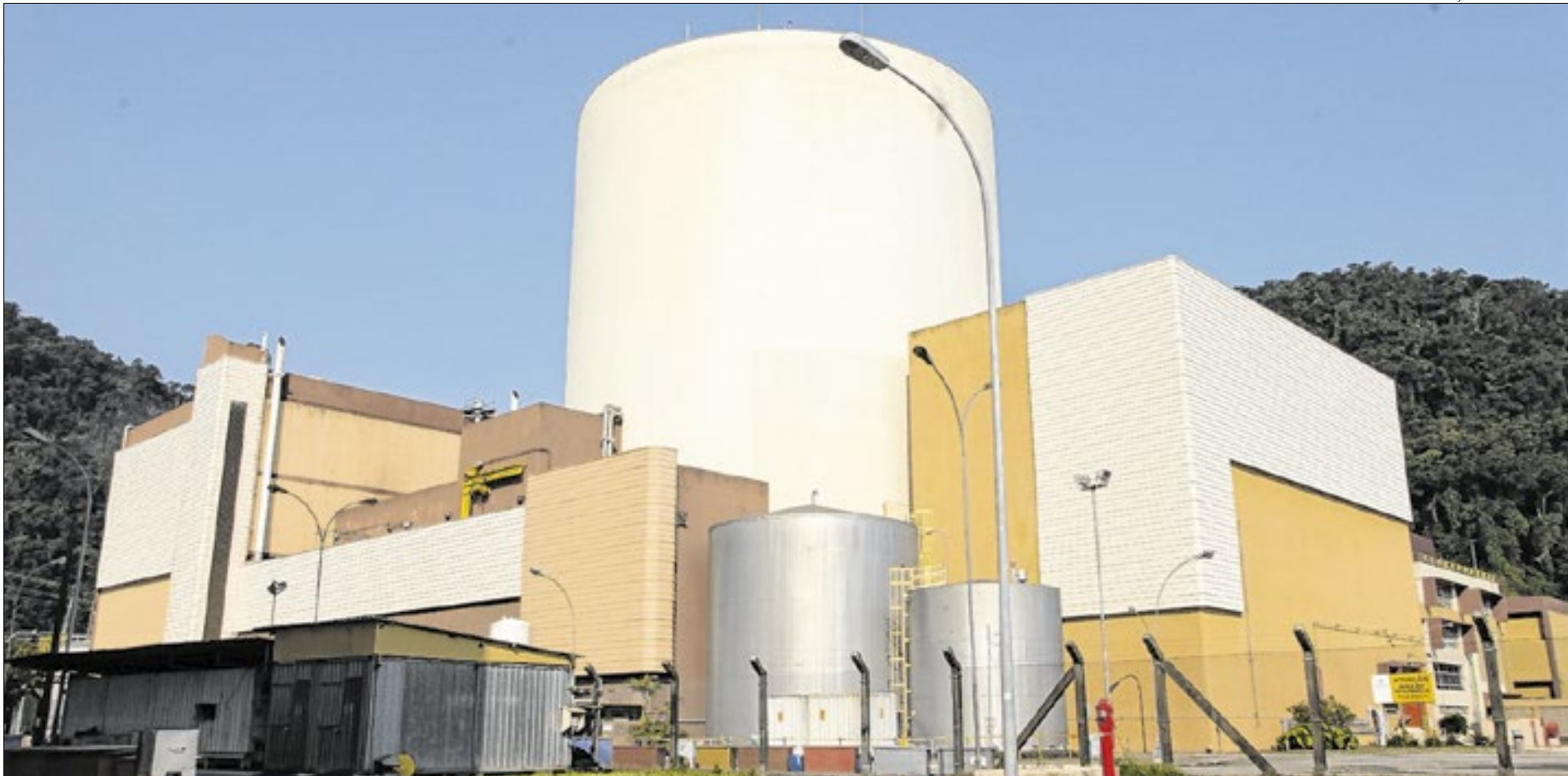
Um dos principais trabalhos da parada é a substituição dos 44 elementos combustíveis do reator; novos elementos foram recebidos em transportes programados e armazenados na PCN
