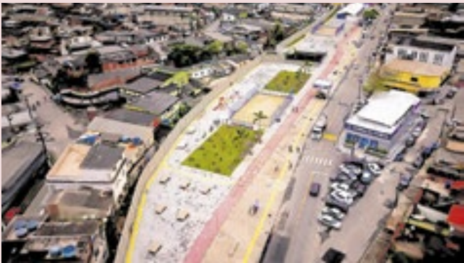
Infraestrutura da região foi melhorada com as obras
