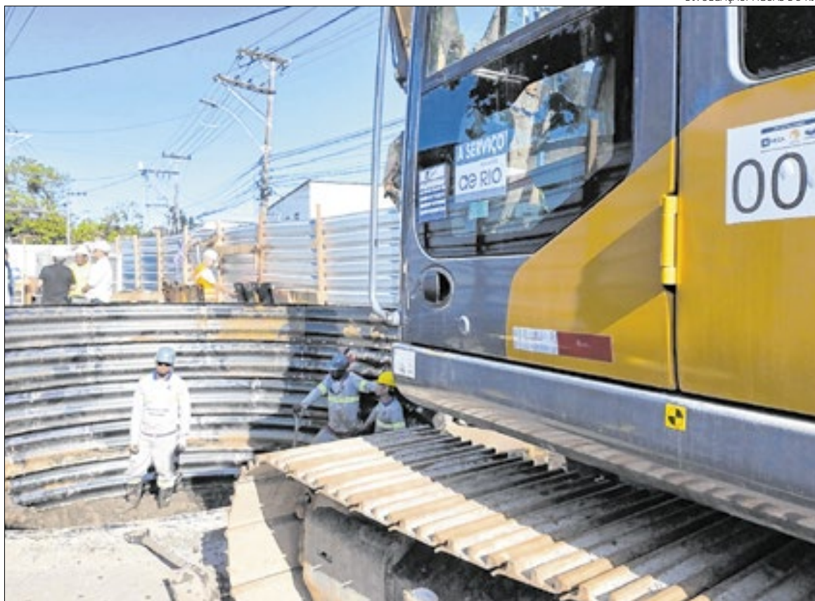
‘Tatuzinhos’ reduzem a necessidade de abrir valas e minimizam impactos durante as obras de saneamento
