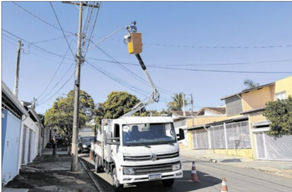
Os serviços atingem diferentes regiões de Valinhos, visando a recuperação dos pontos de iluminação pública
