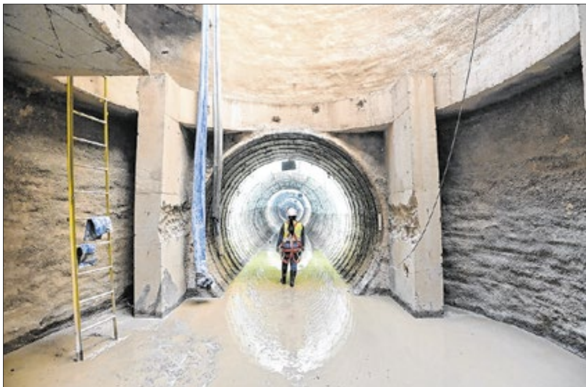
O RP1 integra o conjunto de obras de macrodrenagem de Campinas, tem investimento de R$ 220 milhões
