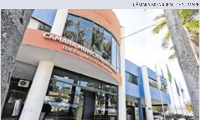
Projeto prevê proteção contra acidentes em portas públicas
