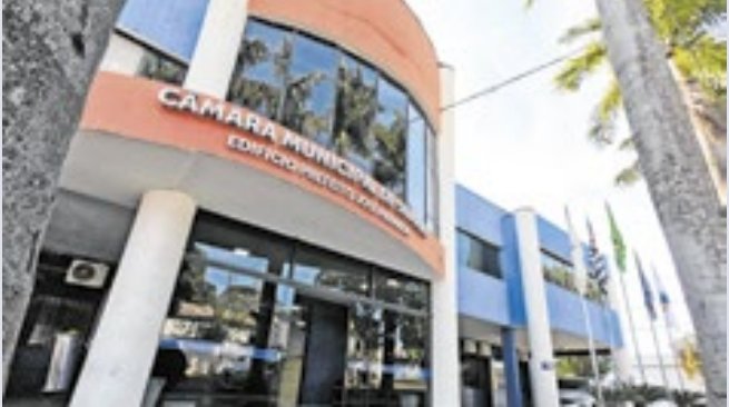
Projeto prevê proteção contra acidentes em portas públicas
