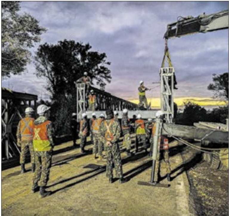
A ponte provisória de Pelotas, instalada em 2024, foi retirada em agosto
