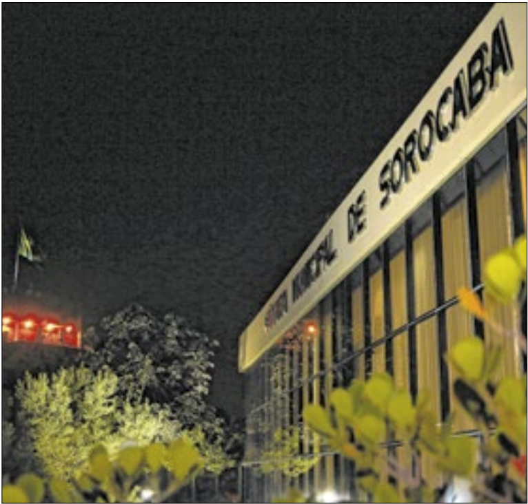
Fachada do prédio do Legislativo em Sorocaba
