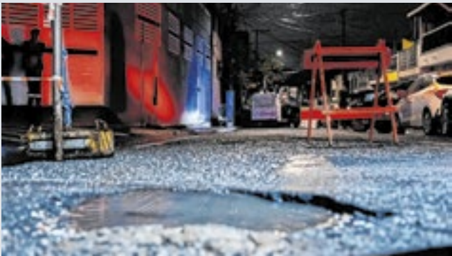
Prefeitura faz recapeamento asfáltico e nova iluminação para bairro
