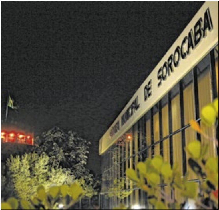
Fachada do prédio do Legislativo em Sorocaba
