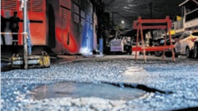
Prefeitura faz recapeamento asfáltico e nova iluminação para bairro
