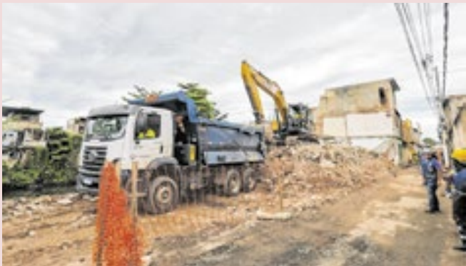
Obra reforça a margem do rio e melhora o escoamento da água
