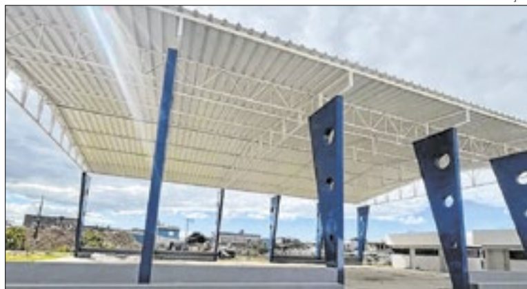
Obras estão na fase final de manutenção e acabamento
