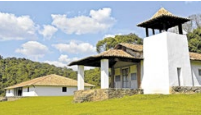
A Casa Grande foi construída a mando de Fernão Paes, em 1640
