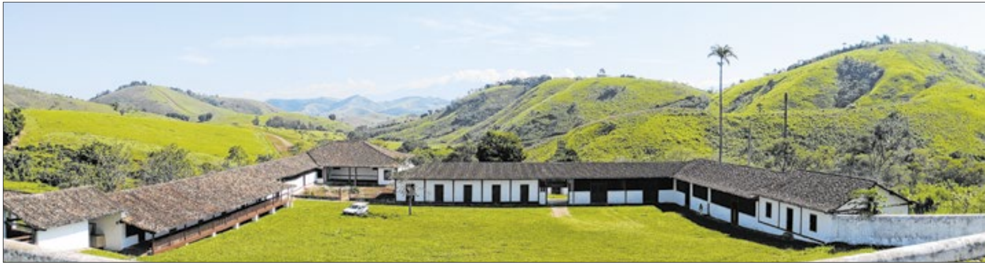
Fazenda Pau D'Alho, em Barão Geraldo: Prefeitura anunciou obra de data center de Inteligência Artificial de R$ 5 bilhões, podendo chegar a R$ 20 bilhões
