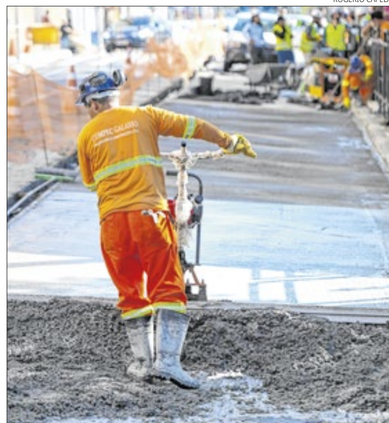
Ordem de Serviço foi assinada em maio; trabalhos começaram em junho
