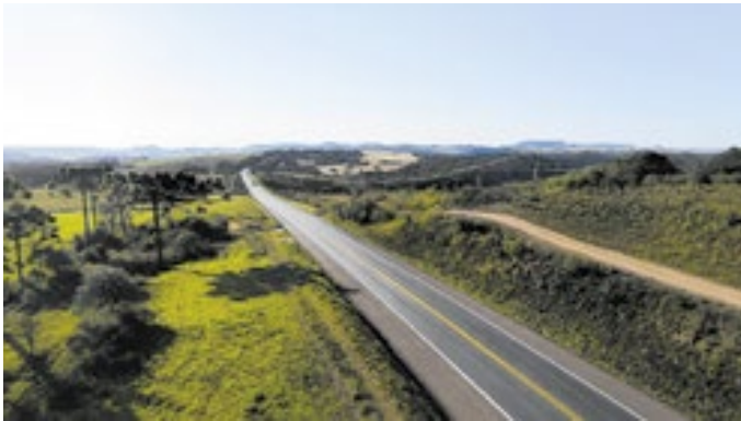
A concessão prevê 12 pórticos para cobrança por livre passagem
