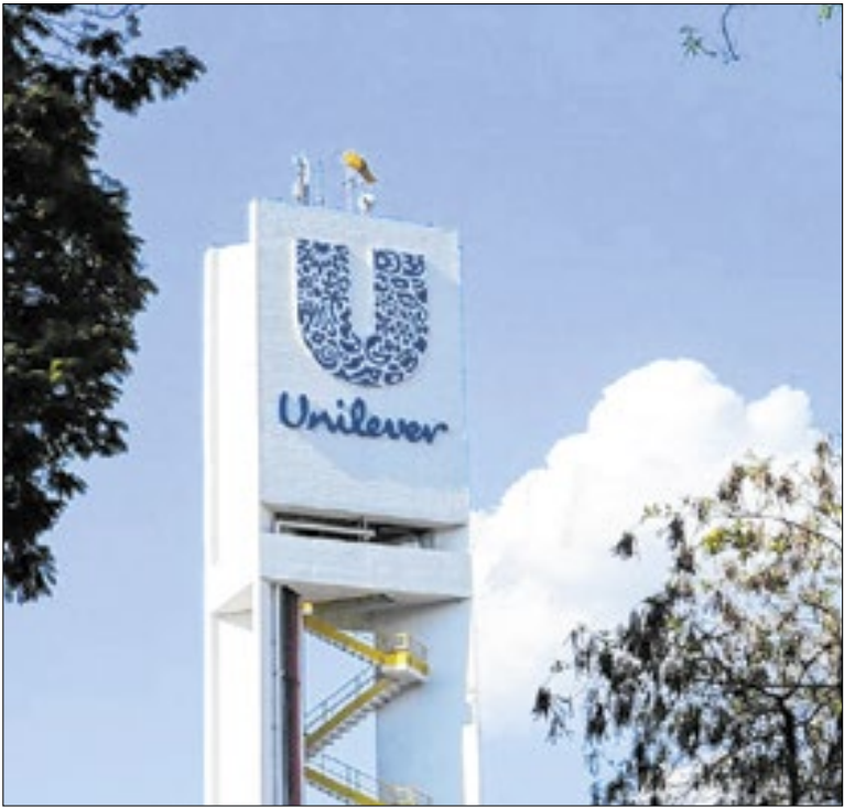
Inspeção encontrou falhas em controles, água e processos de qualidade
